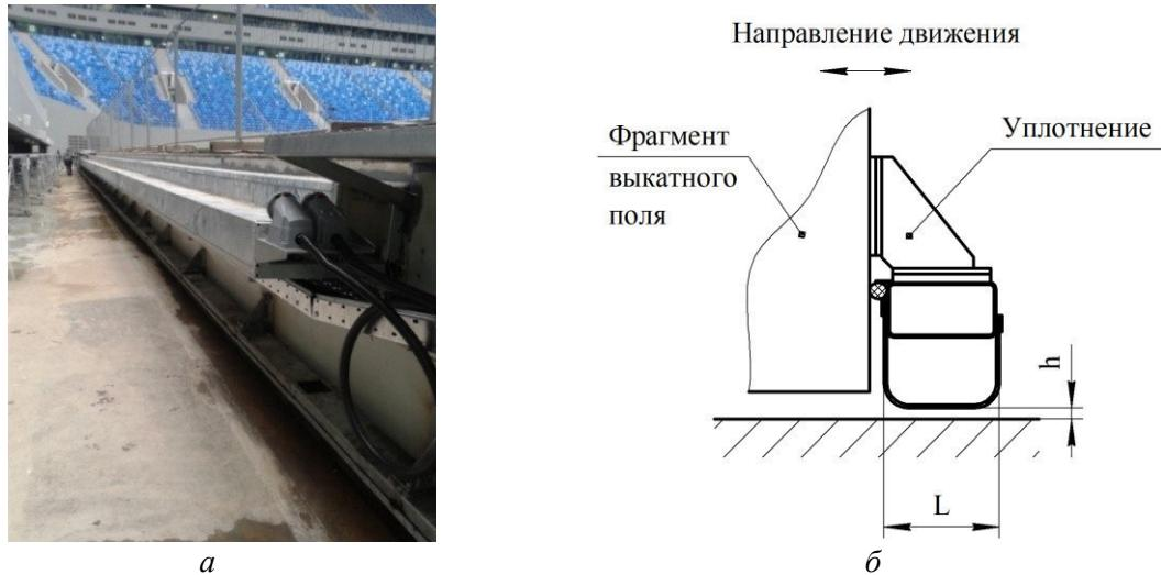
Рисунок 1. Фрагмент выкатного поля стадиона «ГАЗПРОМ-АРЕНА» с установленным на нем уплотнением (а) и его схема (б)
